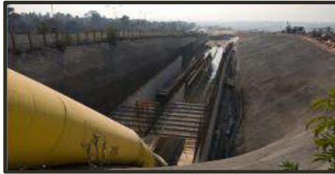
Şekil 3. 1 Aç-kapa metoduyla yapılan bir tünel [31]
