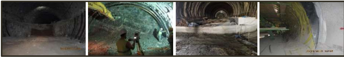
Şekil 3. 4 Tünellerde kazı ve destekleme elemanları (NATM) (Honaz Tüneli)
