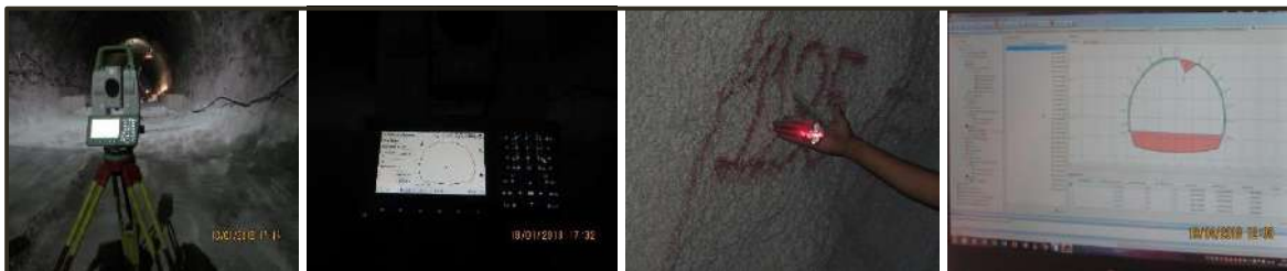
Şekil 6. 11 Total station ile yapılan jeodezik ölçümlerden görüntüler (Honaz Tüneli)
