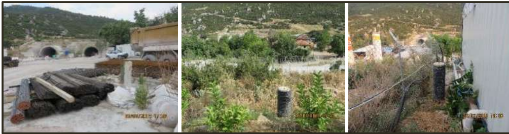
Şekil 6. 5 Honaz Tüneli giriş portalındaki pilyeler
