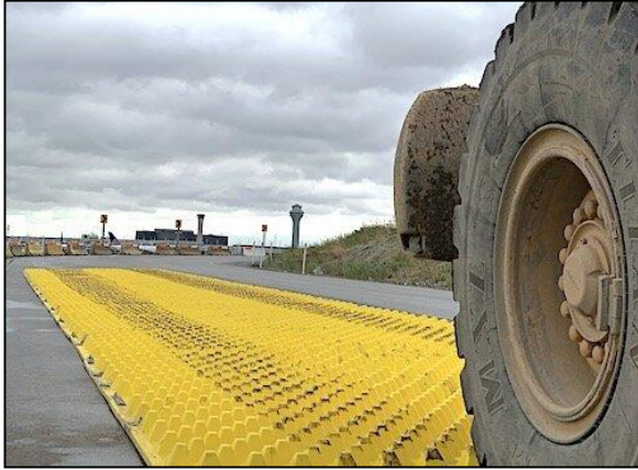
Şekil 2: Araçların piste girmeden önce sarsıntı yüzeylerinin üzerinden geçmesi (Url-4).
