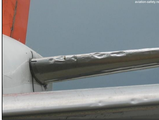
Şekil 22: Uçak kuyruk gövde kısmı sol irtifa dümeninde oluşan hasar (Url-11).
