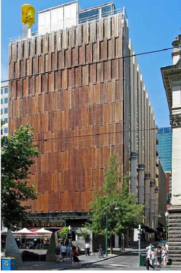
Şekil 25:CH2 Ofis Binası
