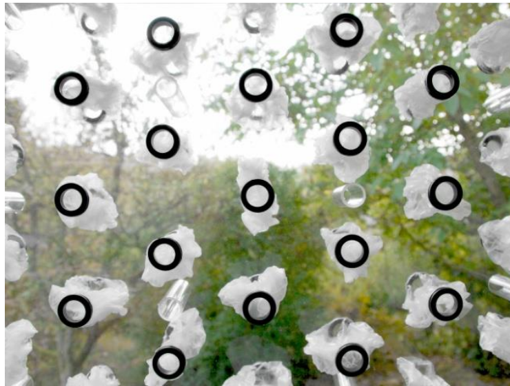
Şekil 17: Pnömatik Cephe Detayı ( URL 7)
