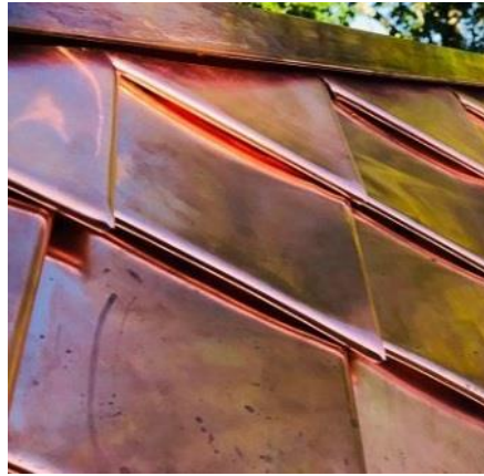
Şekil 11. Bakır çatı kaplaması (URL 8)
