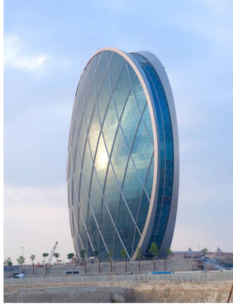
Şekil 15. Aldar HQ cam cephe (URL12)
