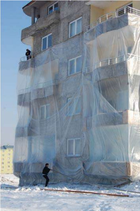
Resim 3.1. Muş'ta soğuktan korunmak için geliştirilen çözüm; paketlenen apartman örneği [URL-5]
